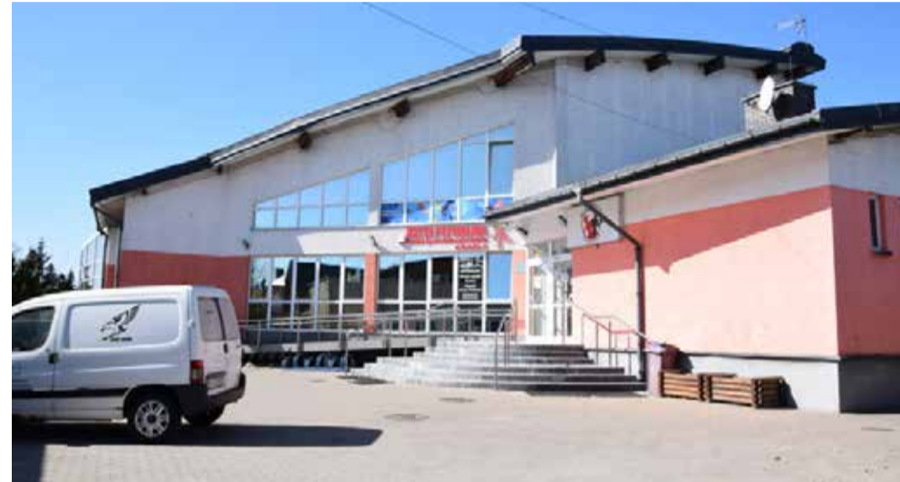
Fot. BASEN OSiR przed remontem i rozbudową
