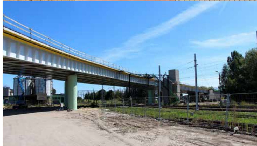
Fot. WIADUK - widok z poziomego ścieżki rowerowej i z ul. Kolejowej
