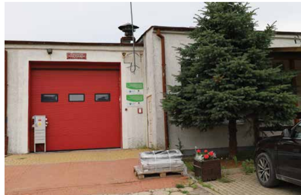
Fot. Siedziba OSP była przebudowywana z własnych środków Gminy Sokółka
