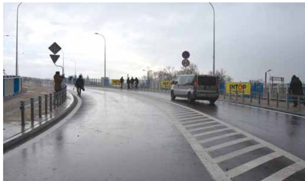
Fot. WIADUKT nad liniami kolejowymi nr 6 i 57
