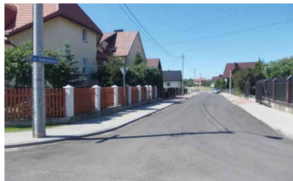
Fot. Budowa ul. NADRZECZNEJ
