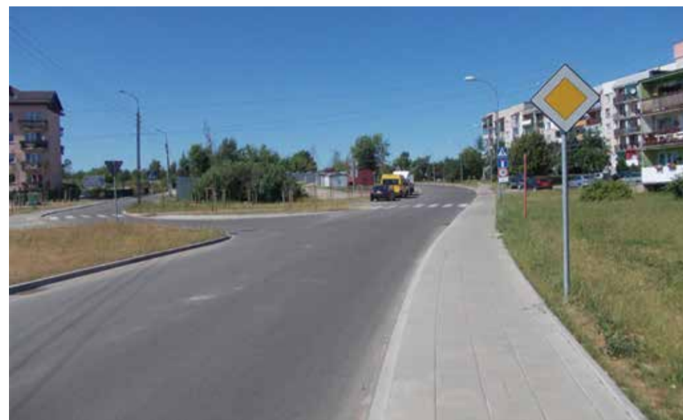
Fot. Przebudowa ul. W. BRONIEWSKIEGO
