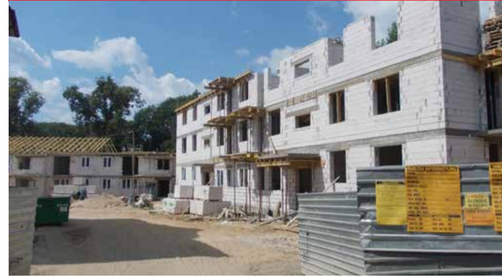
Fot. Budowa bloku KOMUNALNEGO i SOCJALNEGO w Sokółce
