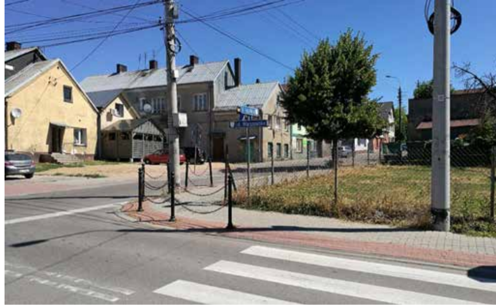
Fot. Rozbudowa WĘZŁA CIEPŁEGO do podłączenia budynków przy ul. Warszawskiej, 1-go Maja i Białostockiej
