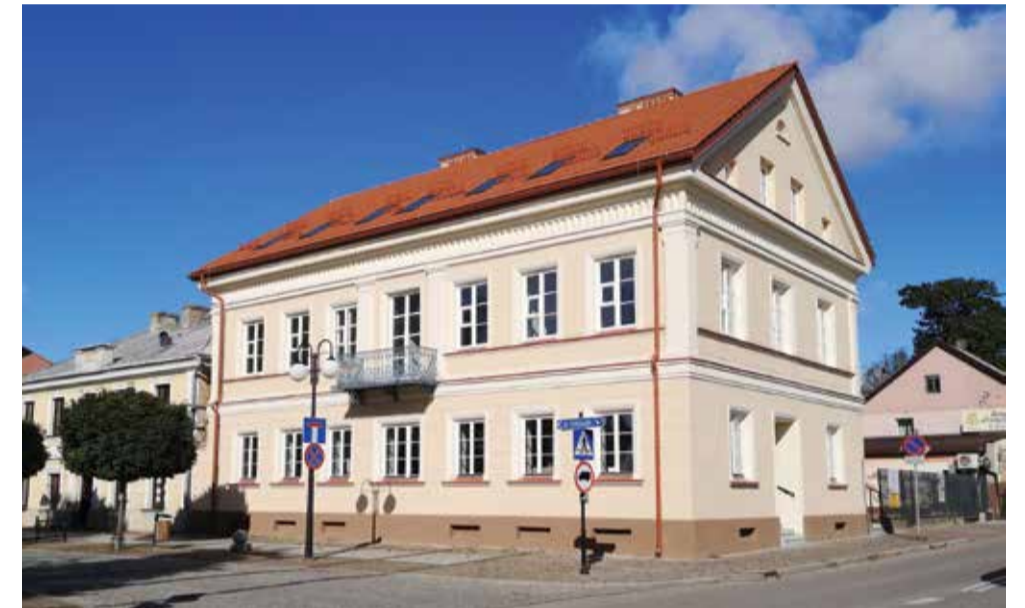
Fot. Remont KAMIENICY TYZENHAUZA przy ul. Piłsudskiego
