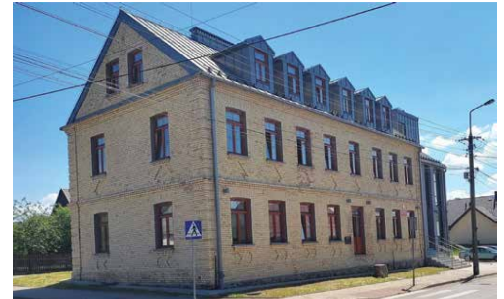
Fot. Przebudowa BUDYNKU POLICJI przy ul. Dąbrowskiego
