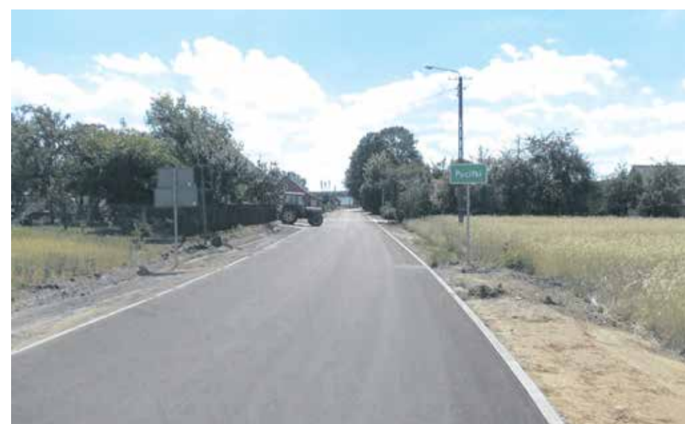
Fot. Budowa drogi w miejscowości PUCIŁKI
