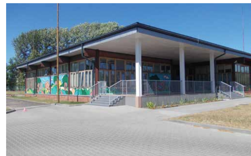
Fot. PRZEDSZKOLE Nr 3 - przebudowa dachu i chodników, drogi dojazdowej i budowa pakingu
