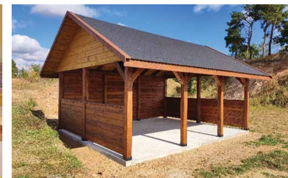
Fot. Budowa WIATY REKREACYJNEJ w Nomikach
