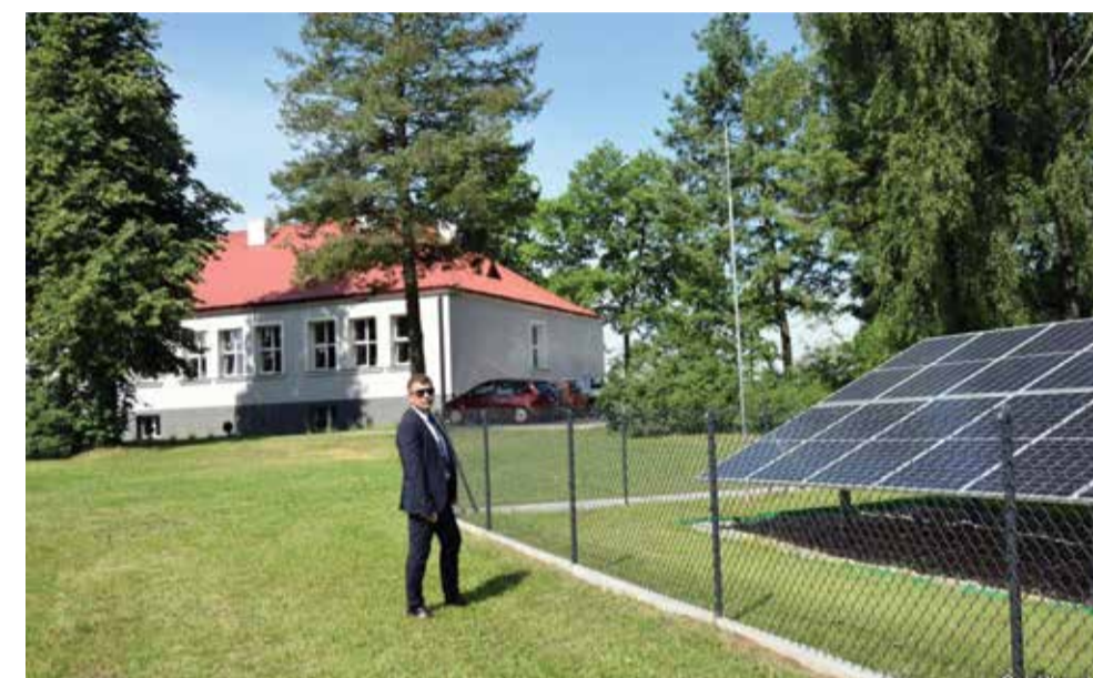
Fot. TERMOMODERNIZACJA Szkoły Podstawowej w Starej Rozedrance
